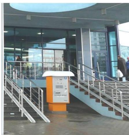
Рисунок 6.30 – Недопустимые конструкции входных пандусов для инвалидов
