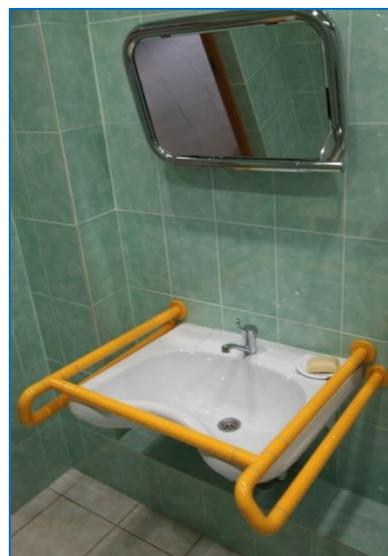
Зеркало установлено слишком высоко. Имеется возможность изменения угла наклона, но ручка у зеркала вне зоны досягаемости инвалида.
