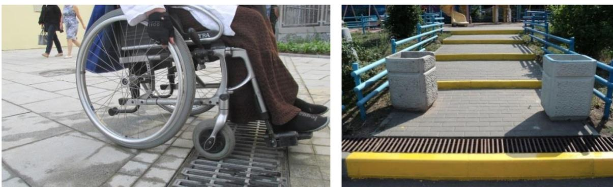
Рисунок 5.23 – Возможно застревание колес в продольных отверстиях решетки
