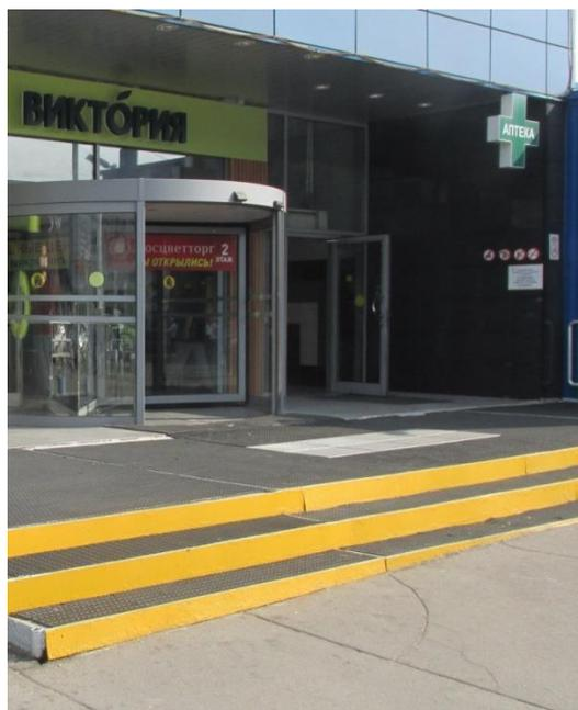
Рисунок 6.24 – Неправильная маркировка: выделен цветом только подступенок
