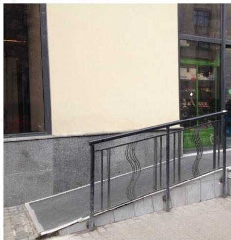
Рисунок 6.40 – Недопустимые решения по установке поручней на пандусе
