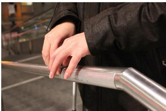
Рисунок 10.17 – Положение рук при чтении тактильной таблички на поручне
