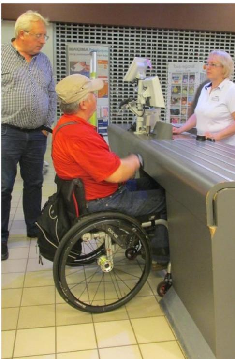
Рисунок 7.19 – Ниша на стойке расчетно-кассового узла для фронтального подъезда под нее низом коляски
