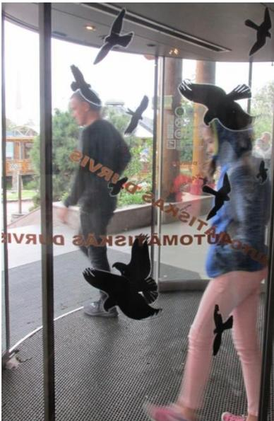
Рисунок 6.63 – Примеры маркировки стеклянных поверхностей
