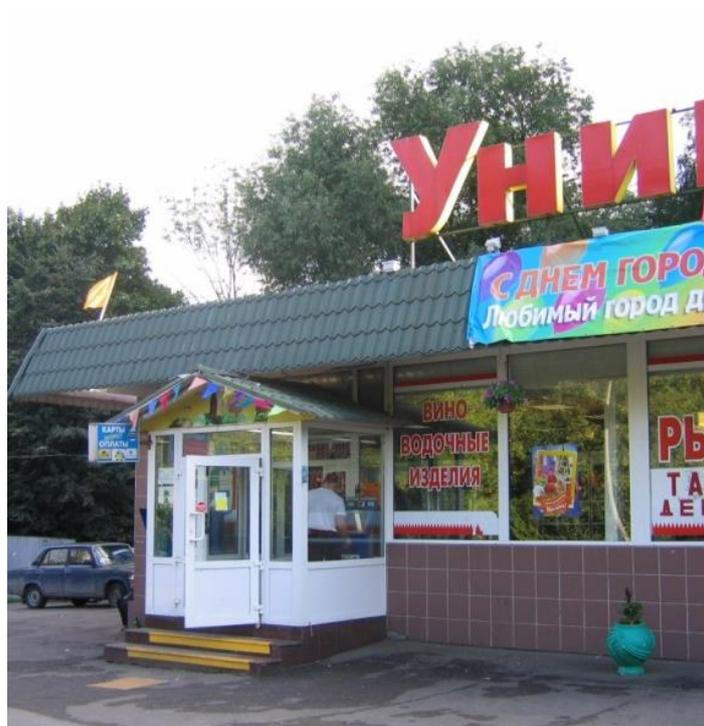
Рисунок 6.9 – Недопустимое решение входной площадки для доступа инвалидов
