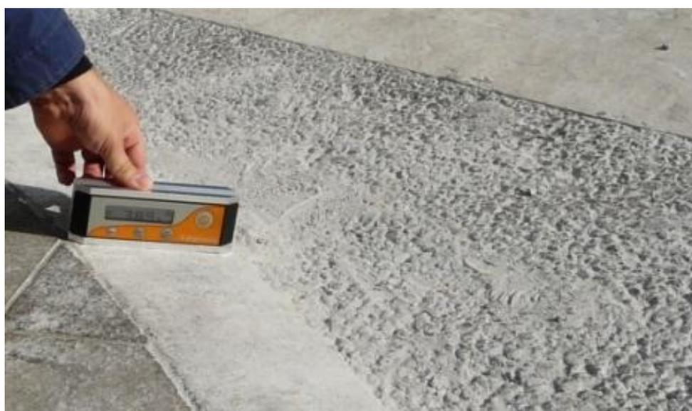
Рисунок 5.14 – Недопустимые конструкции съездов как по уклону, так и по расположению съезда на проезжей части
