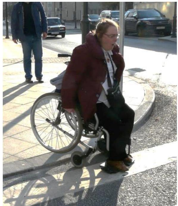
Рисунок 5.12 – Травмоопасная ситуация для человека в кресле-коляске при крутом спуске
