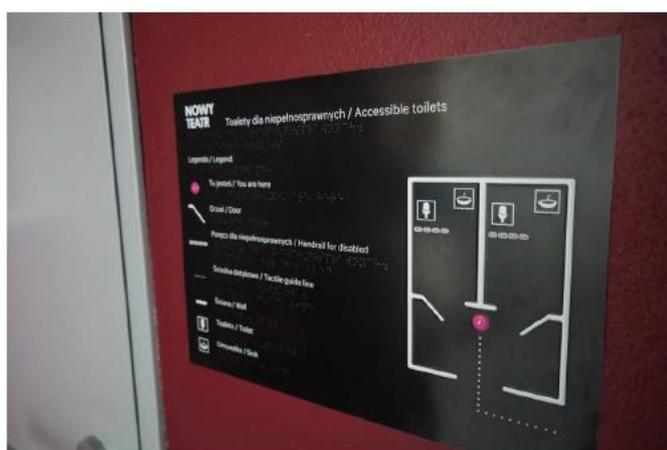
Рисунок 10.21 – Пример тактильной схемы у входа в санузел
