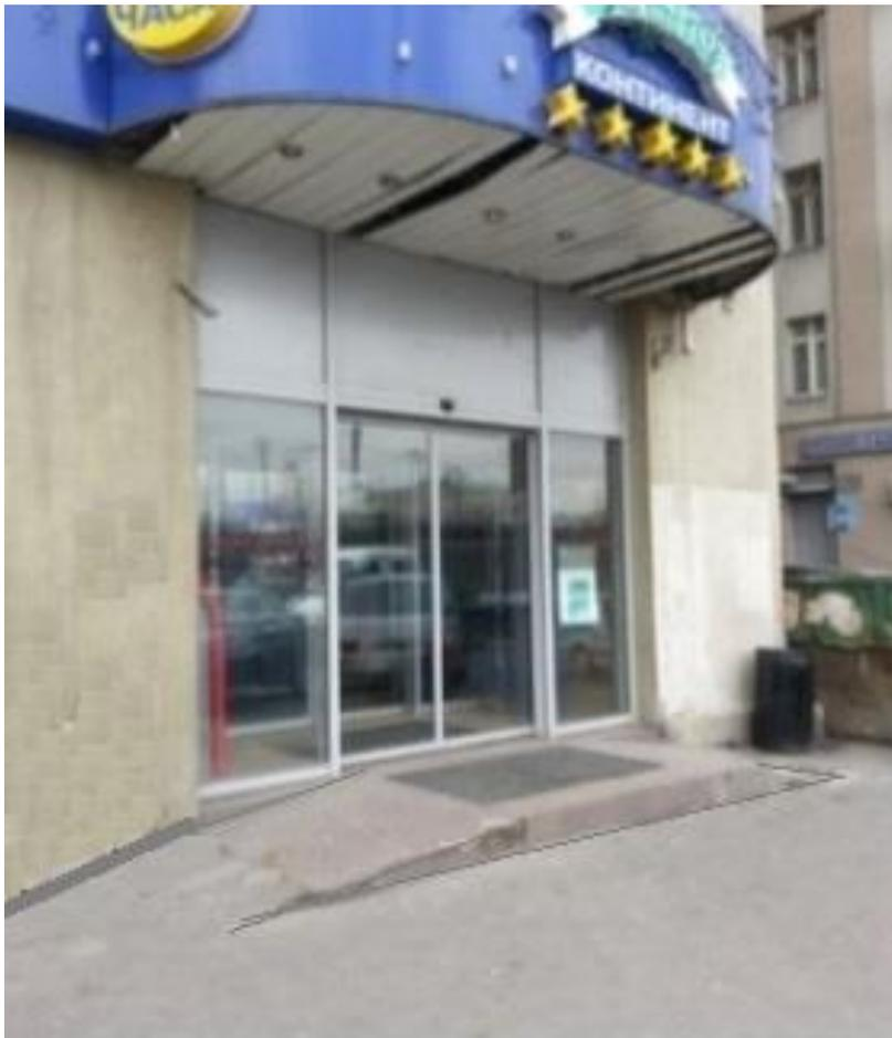
Рисунок 6.7 – Решение входной площадки с автоматическими входными дверями при недостаточных габаритах входной площадки
