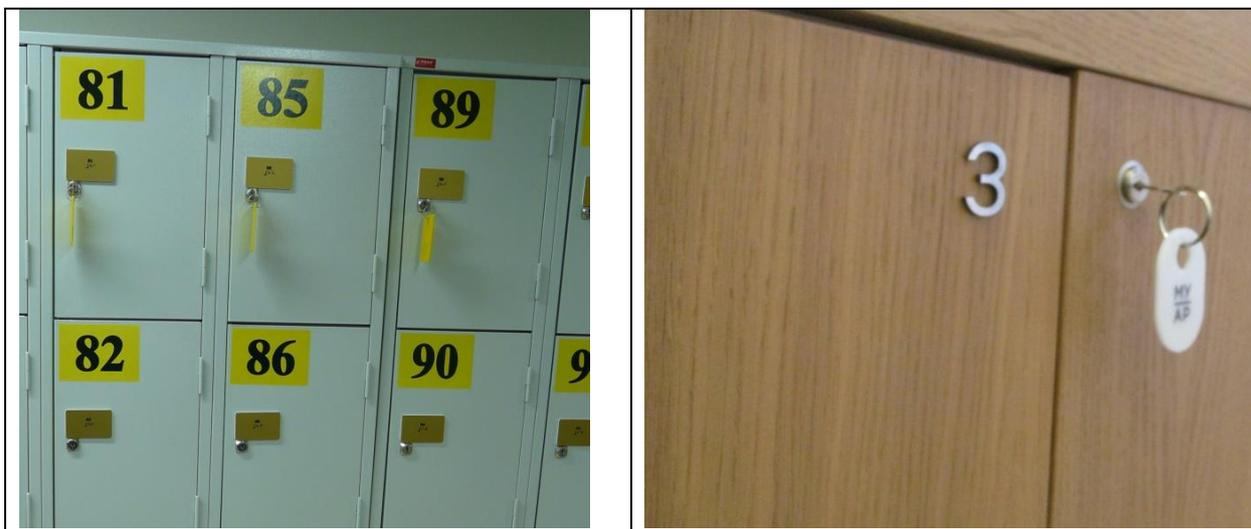
Рисунок 10.22 – Нумерация ячеек хранения в магазине крупным контрастным шрифтом и дублирование их рельефно-точечным шрифтом Брайля для слепых
