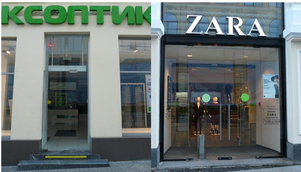
Отсутствие маркировки на стеклянных полотнах дверей недопустимо
