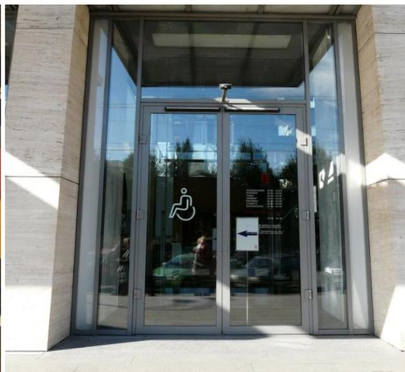
Автоматическая распашная дверь на специальном входе для инвалидов, срабатывающая от датчика движения
