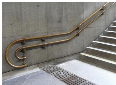
Поручень вдоль стены допустим на длину более 0,33 м
