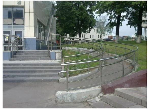
Рисунок 6.42 – Винтовые (криволинейные) пандусы применять не рекомендуется
