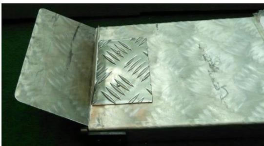
Рисунок 6.88 – Опорная площадка в верхней части переносного пандуса
