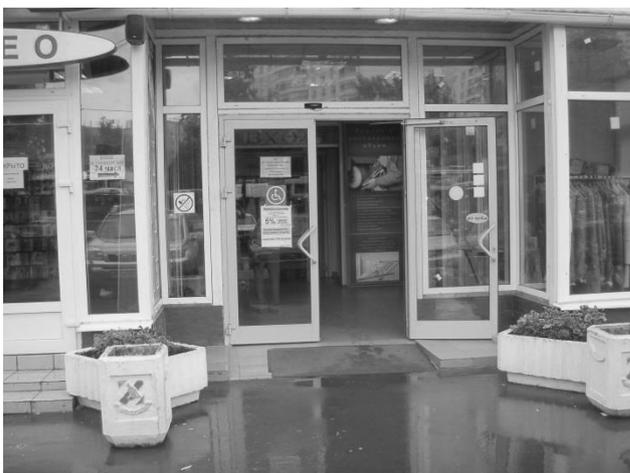
Рисунок 6.4 – Недопустимое решение входной площадки с пандусом, расположенным непосредственно у входной двери
