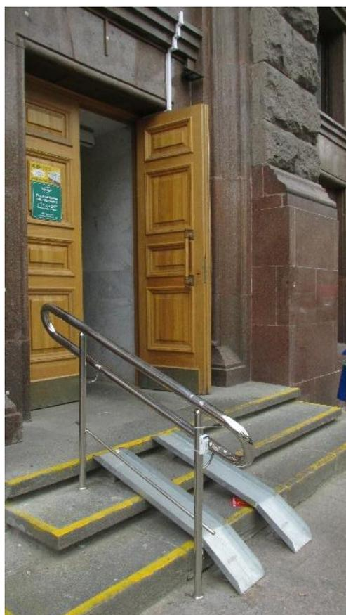
Рисунок 6.31 – Недопустимые на путях движения инвалидов конструкции (аппарели)
