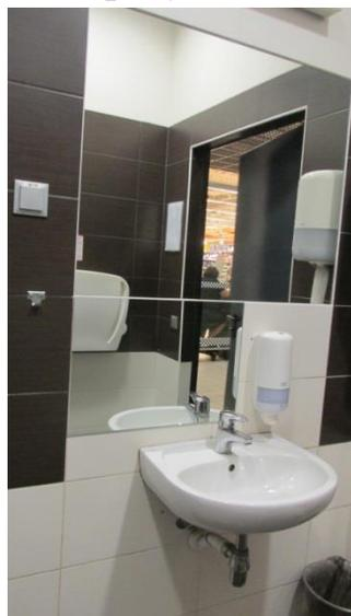
Для возможности установки дозатора с мылом нижняя часть зеркала выполнена только с одной стороны раковина (слева)
