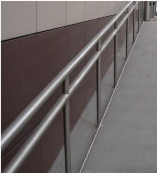
Рисунок 6.38 – Недопустимые варианты крепления поручней
